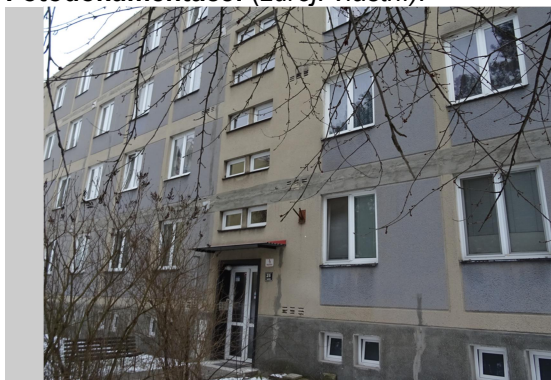
Pohled celkový na bytový dům Nejedlého ev.č.376
